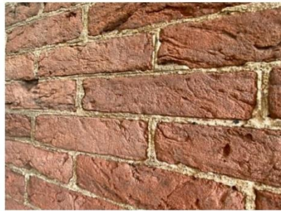
AFBEELDING 11, VOEGWERK MET DAGGESTREEP
