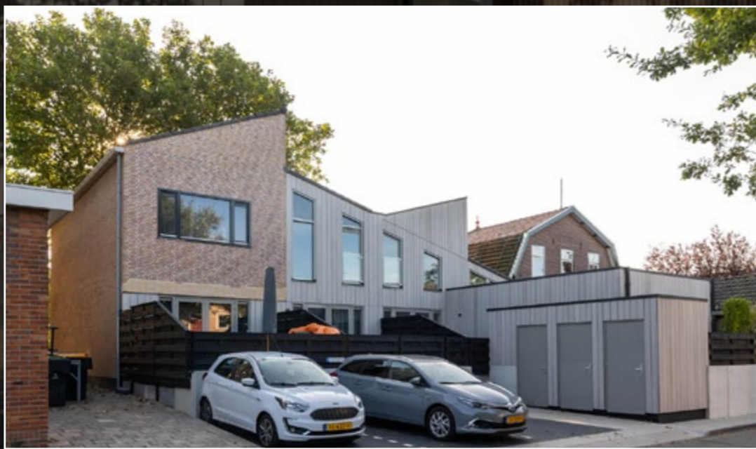
Achterzijde getransformeerde kerk in Broek op Langedijk. Bron: Studio S3
