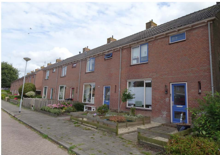
De woningen aan de Bhielstraat voor renovatie. Beeld: MOOI Noord-Holland.
