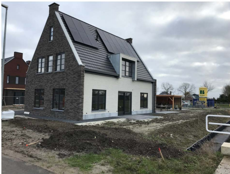
Enkele woningen in Reigersborg Zuid in aanbouw. Beeld: MOOI Noord-Holland.
